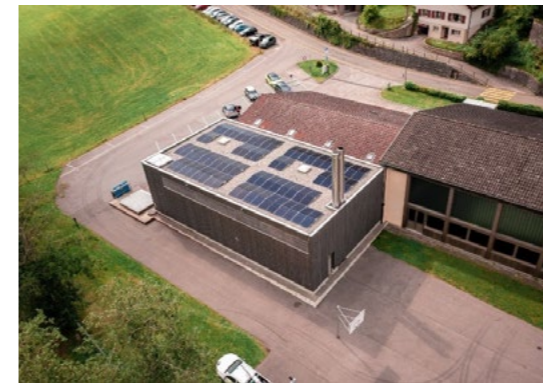
Centrale de chauffe au chemin des Saules à Saint-Ursanne
